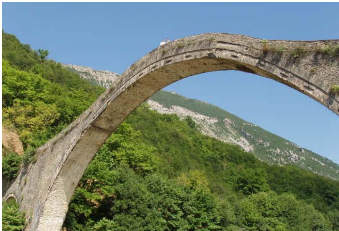
Εικόνα 1. Αποψη του γεφυριού της Πλάκας
